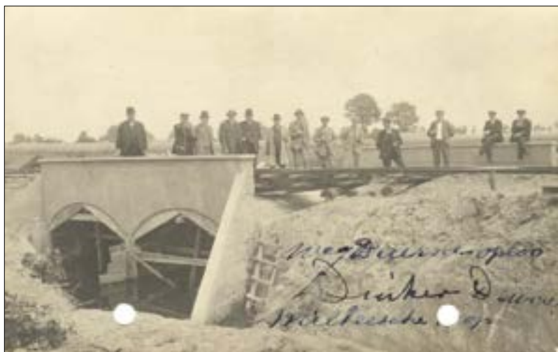
Afbeelding 2. Bezoek notabelen aan aanleg duiker in Kaweische Loop, onder de te verhardende Milheezeweg (1922).
